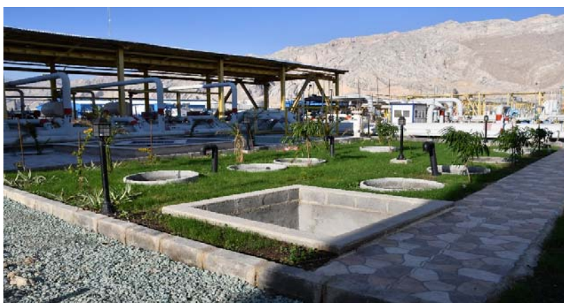
نمای بیرونی تصفیه خانه فاضلاب بهداشتی واحد رستوران
